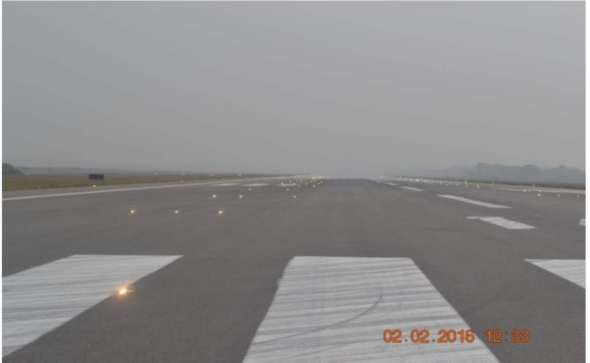
হশাআবি'র রানওয়ে এসফল্ট কনক্রিট ও ভারলে করার পরবর্তী অবস্থা
